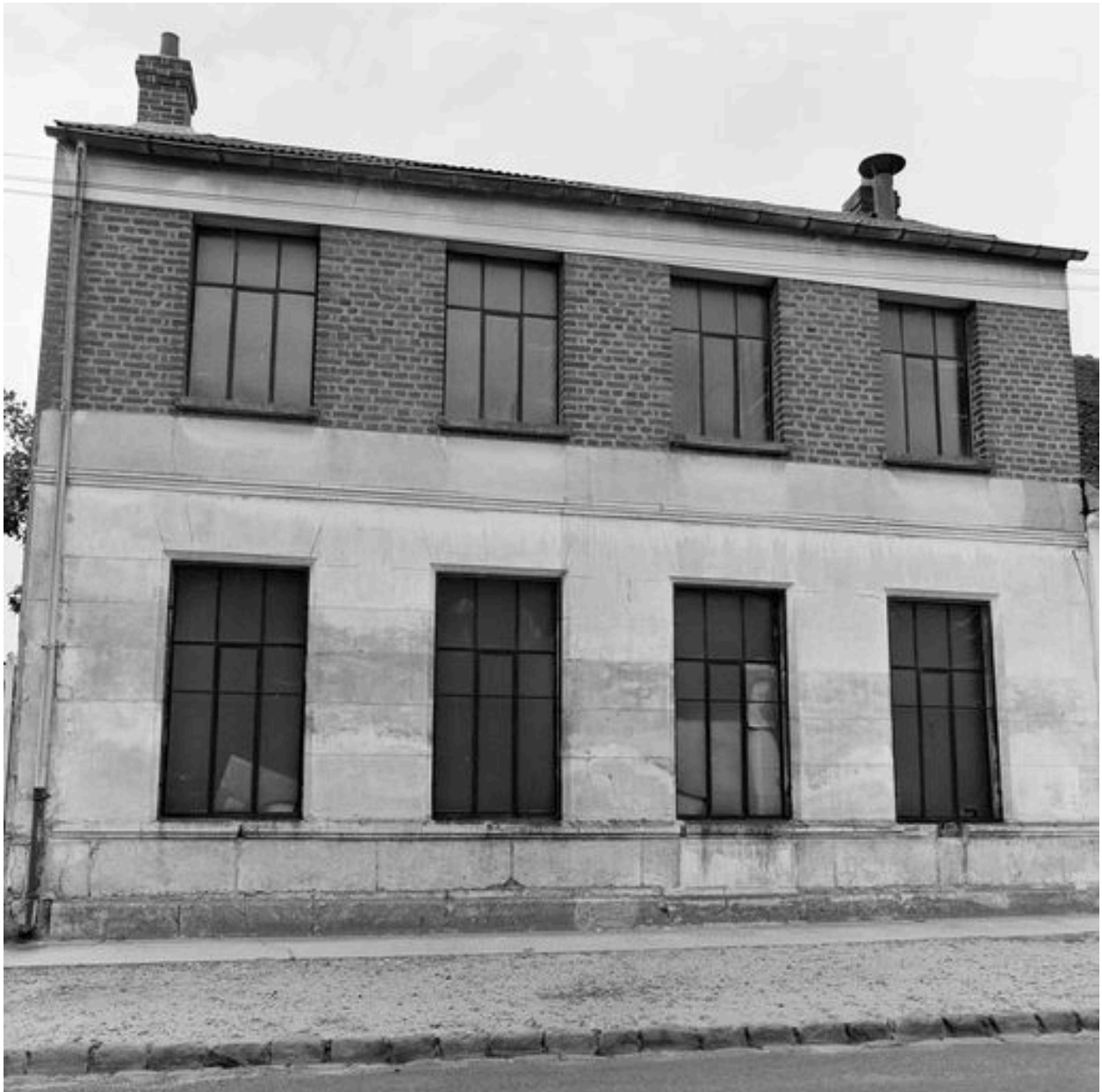
Atelier de fabrication, élévation antérieure.
