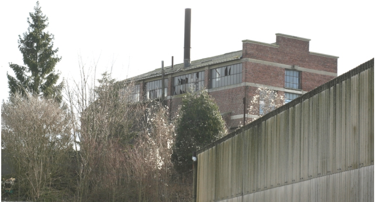
La centrale thermique, vue depuis les entrepôts.
