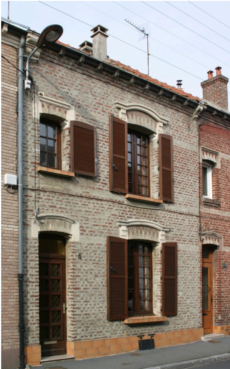
Façade antérieure de l'un des logements du groupe de huit.
