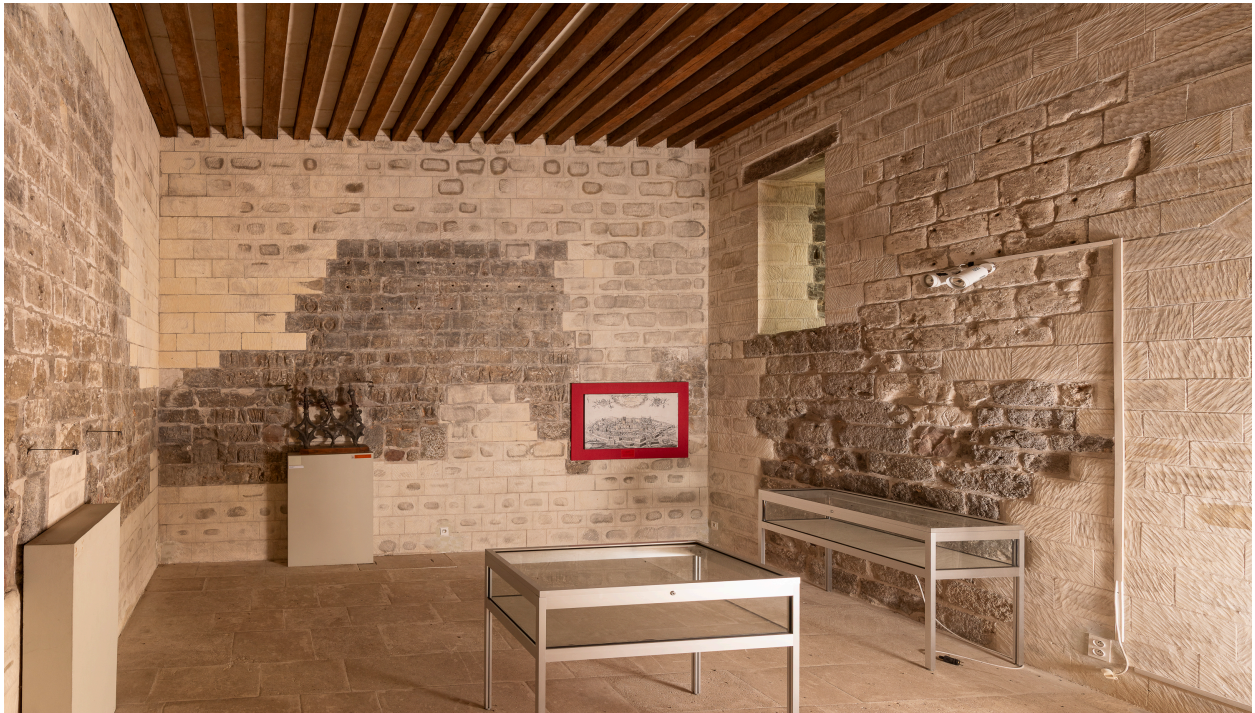
Vue générale de la salle haute.
