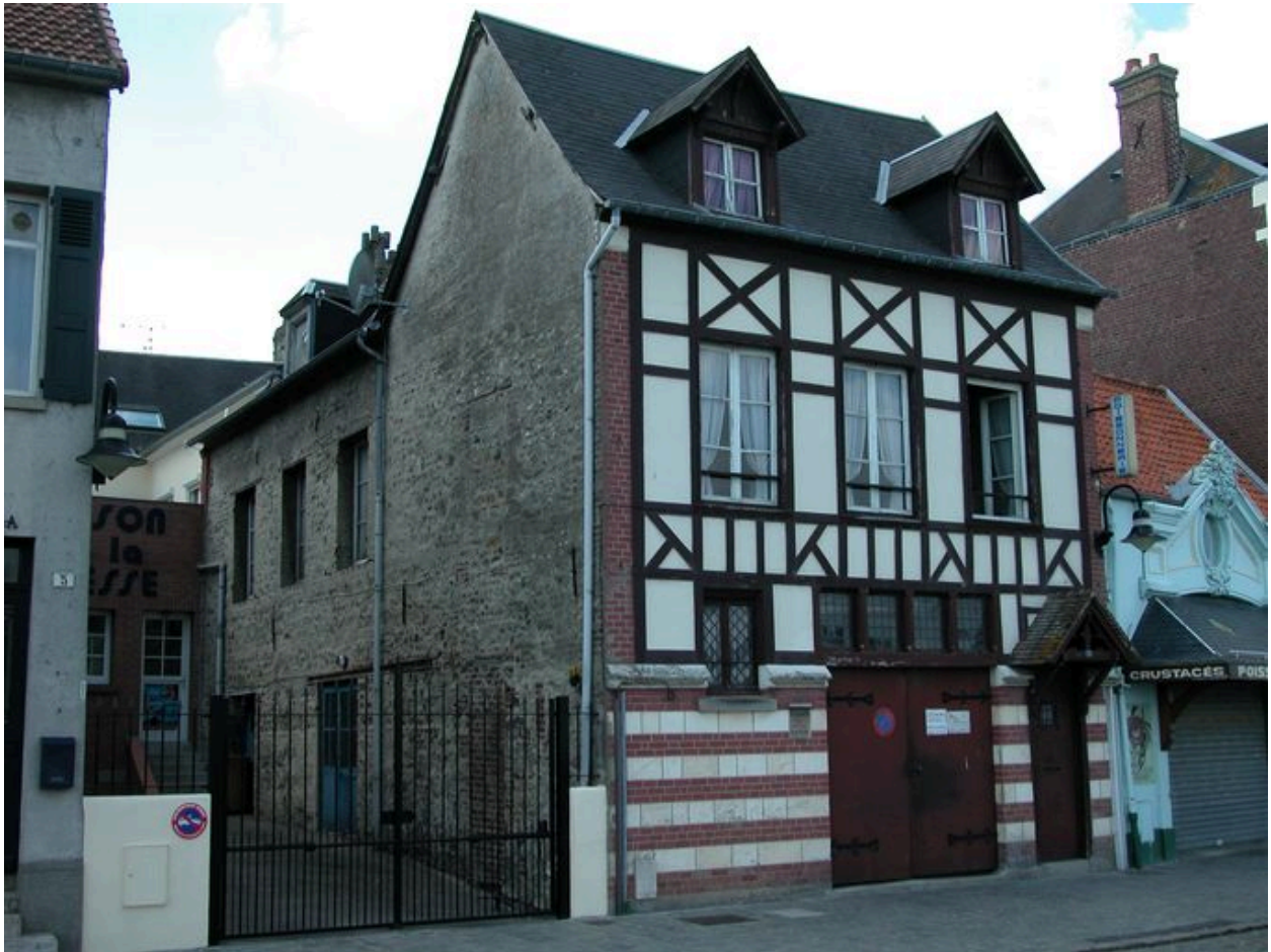
L'Abri Côtier, maison ancienne remaniée par l'architecte Ansart au cours de l'entre-deux-guerres, 7 quai Blavet (AI 172).
