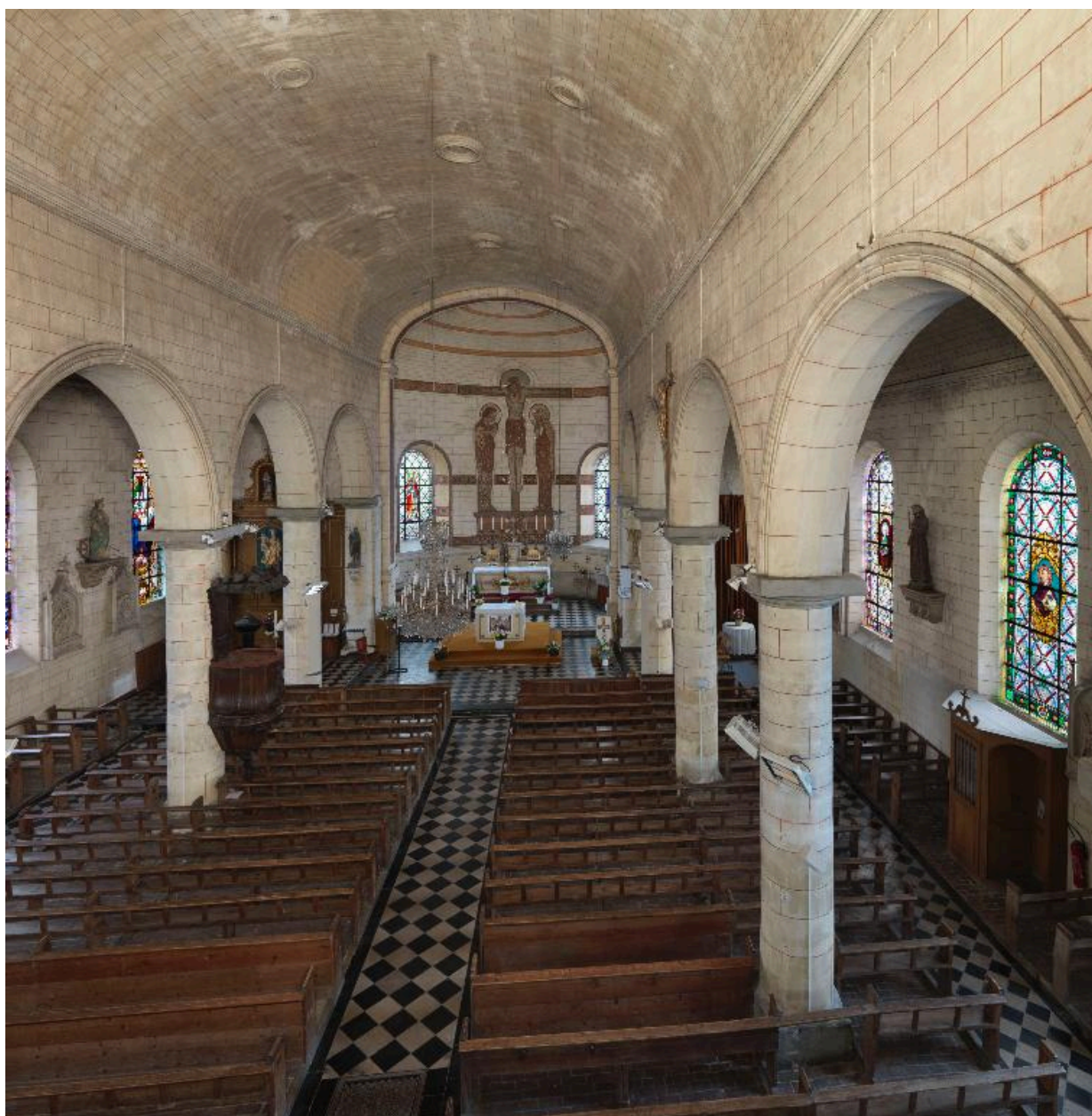
Vue de la nef et du chœur.
