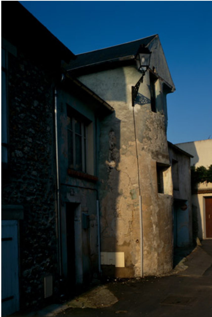
Tourelle d'escalier au 56, rue du Village Saint-Martin.
