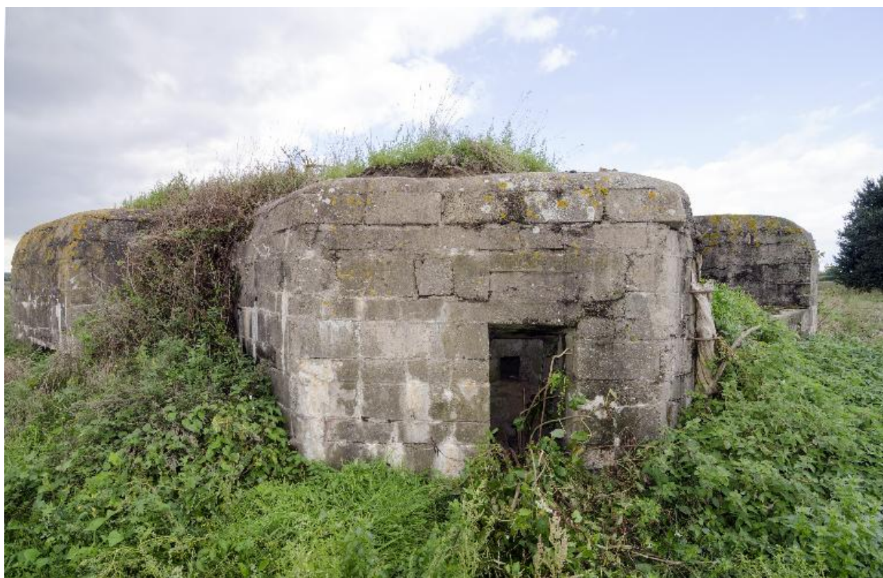
Vue de trois-quarts, vers nord-ouest. Entrée sud-est
