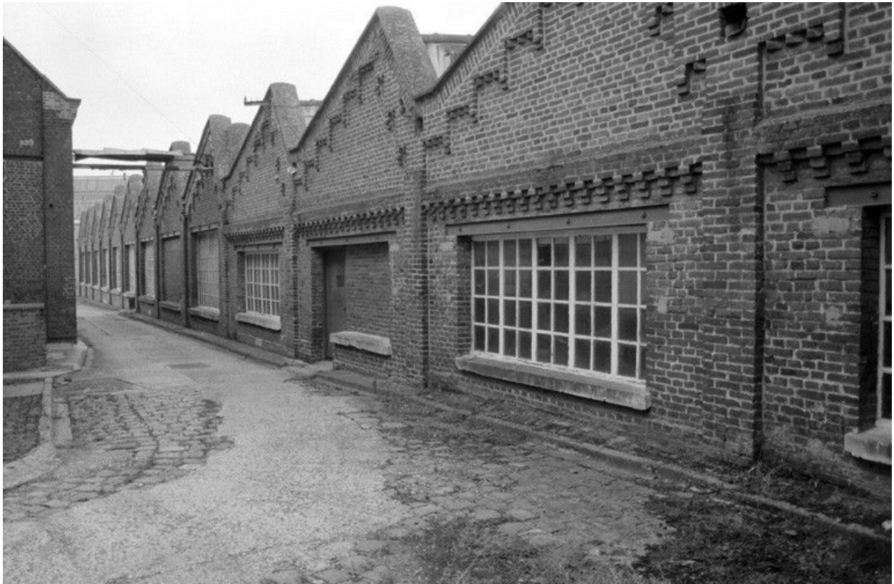
Atelier de fabrication, flanc est.
