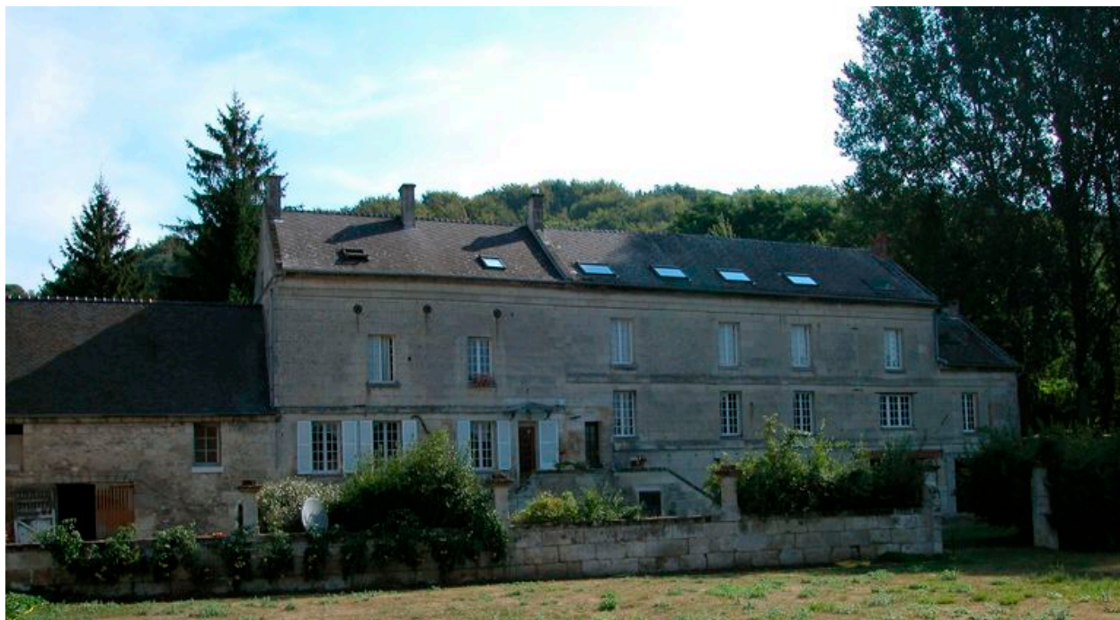
Vue de la façade postérieure
