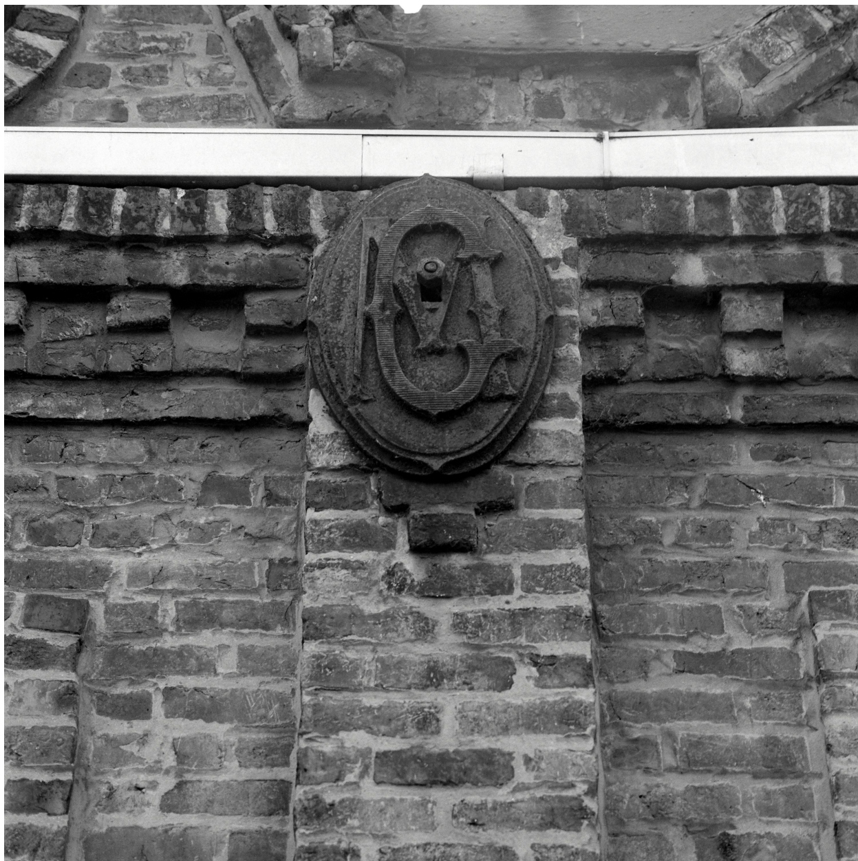
Atelier de fabrication, fer d'ancrage au monogramme MC.
