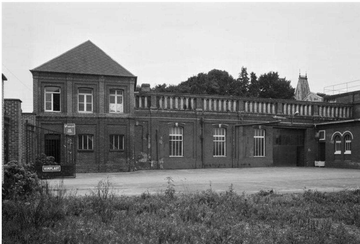
Atelier de fabrication et bureau, flanc est.
