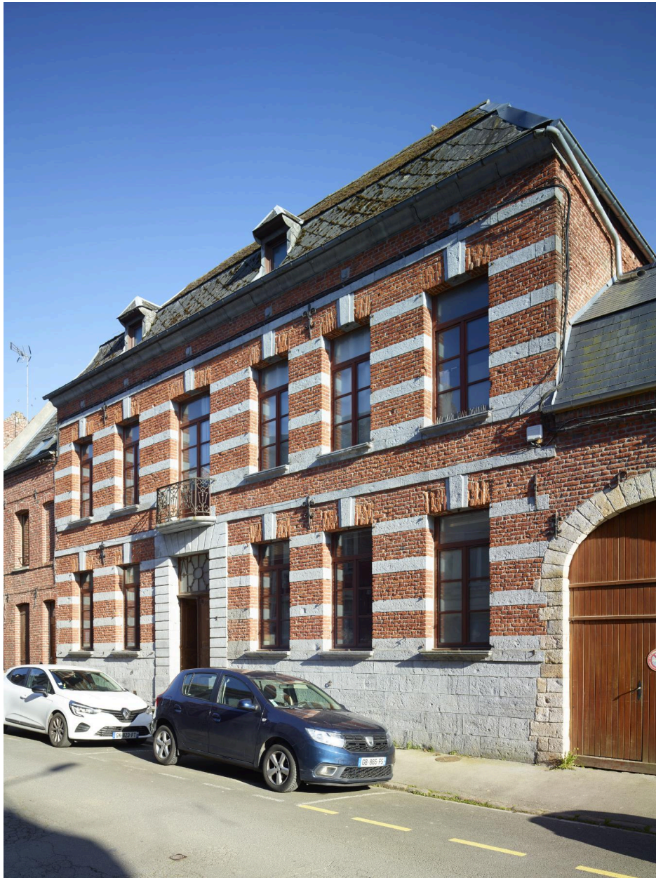
Façade principale de la maison sur la rue George-V. Vue orientée sud-ouest/nord-est.
