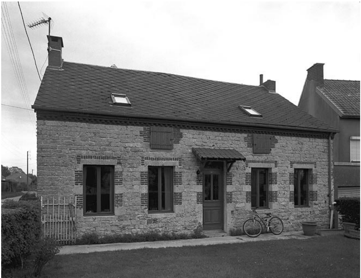
Vue générale de la maison située 55 rue Pasteur.
