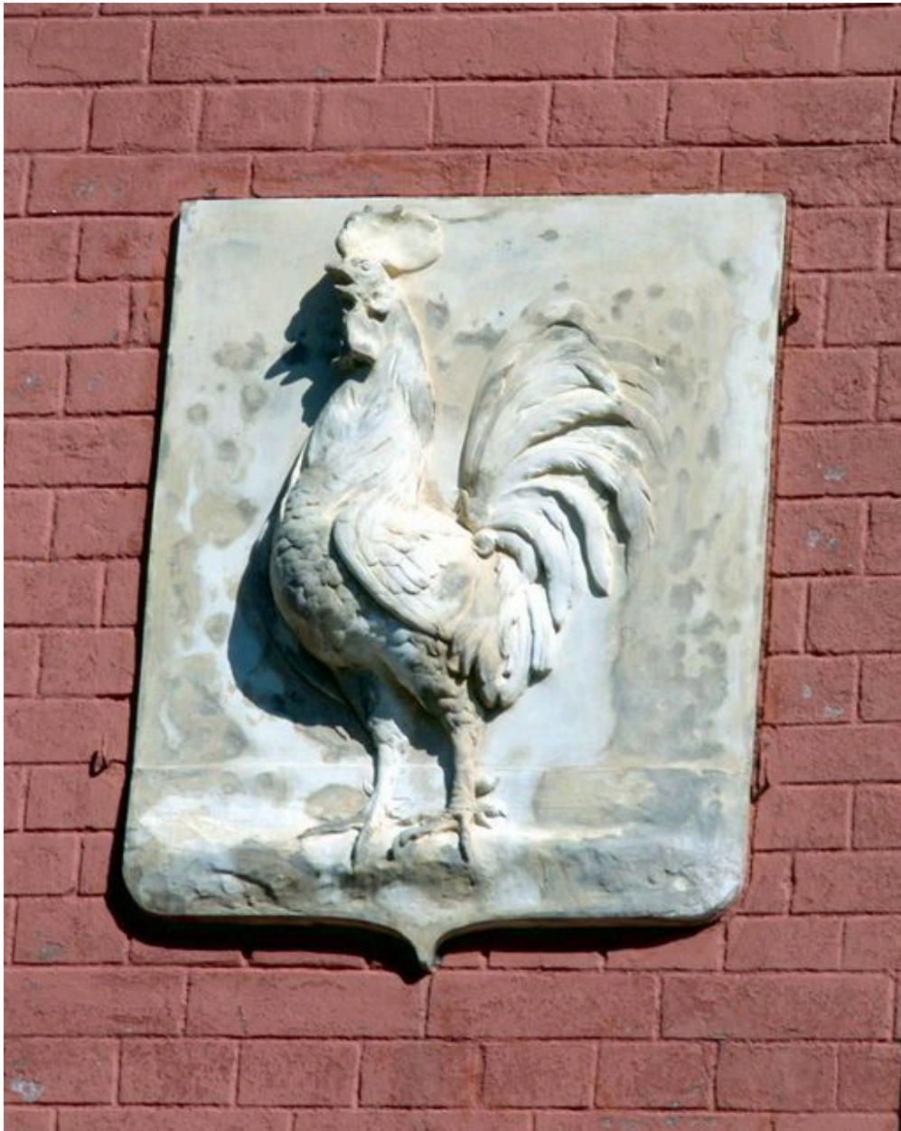
Détail du coq sculpté ornant la façade.
