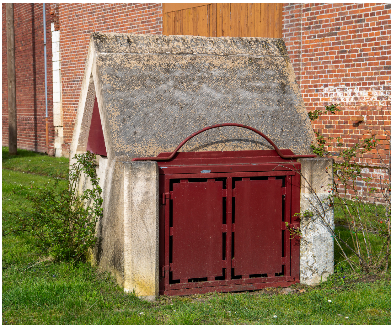
Puits de la rue Dufour.
