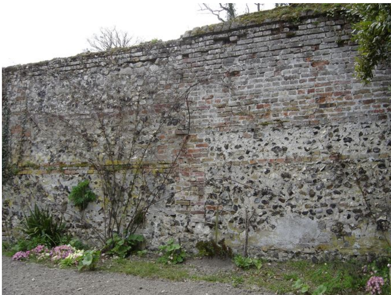
Détail du mur de clôture.
