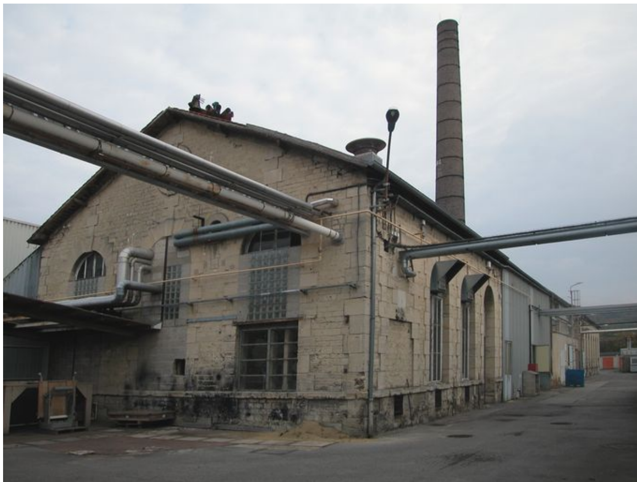
Atelier de fabrication avec la chaufferie en prolongement.
