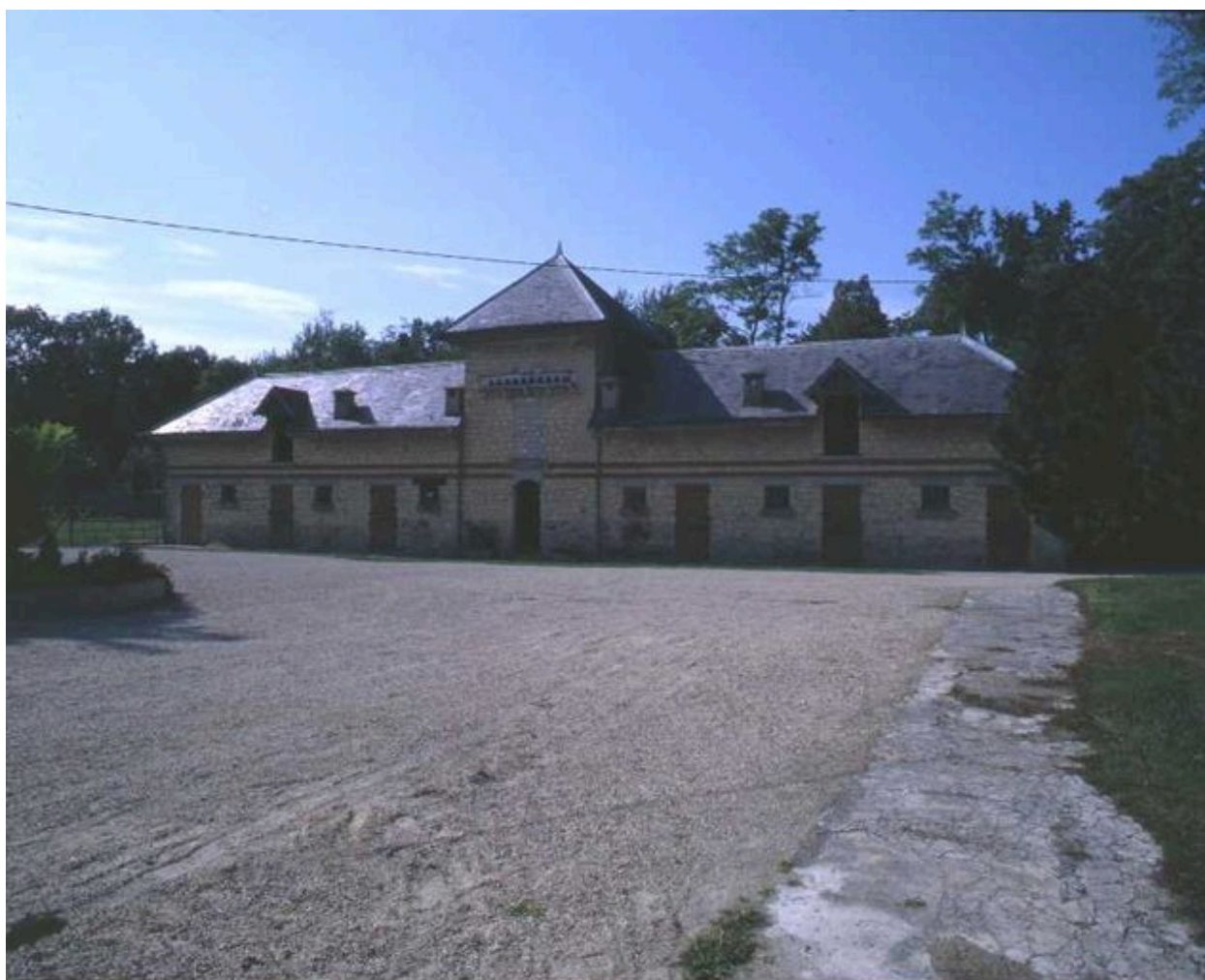
Bâtiments agricoles depuis la cour.
