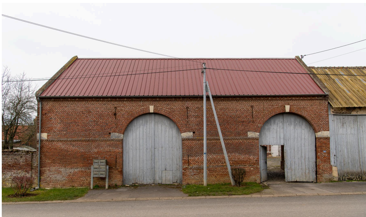
Grange sur rue, n°384 rue des Marronniers, vue depuis l'est.
