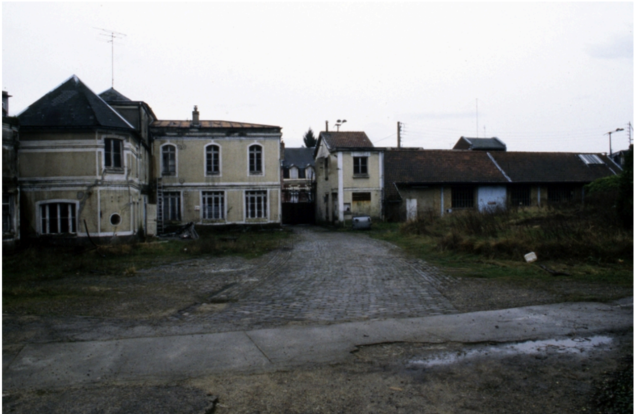
Les garages, bureaux et conciergerie, vue d'ensemble sur cour, 2001.
