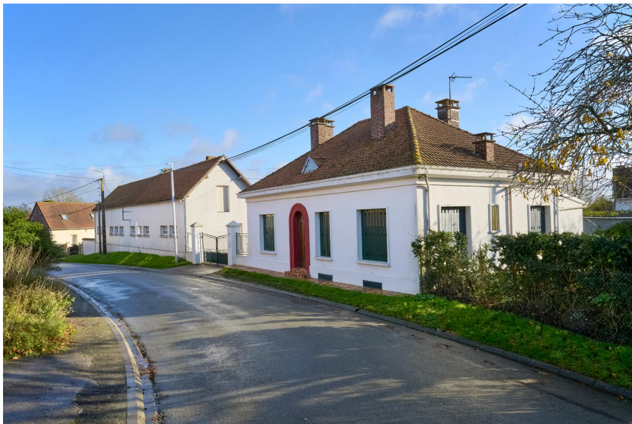
Exemple de ferme de la reconstruction, 4 rue d'Abbeville.
