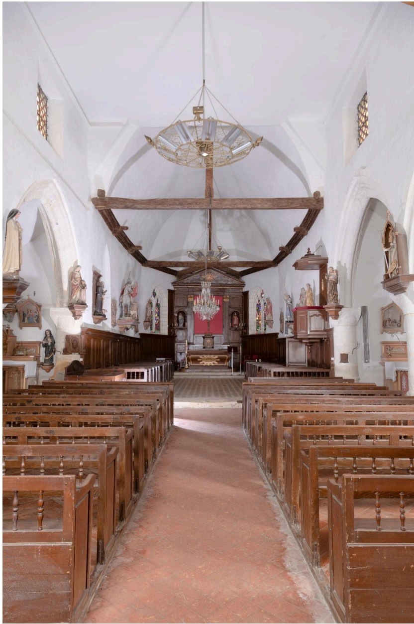
Vue générale vers le choeur.
