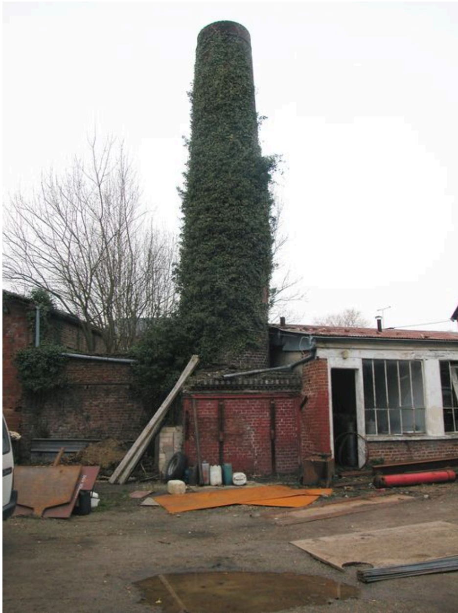
La cheminée attenante à l'ancienne salle des machines.
