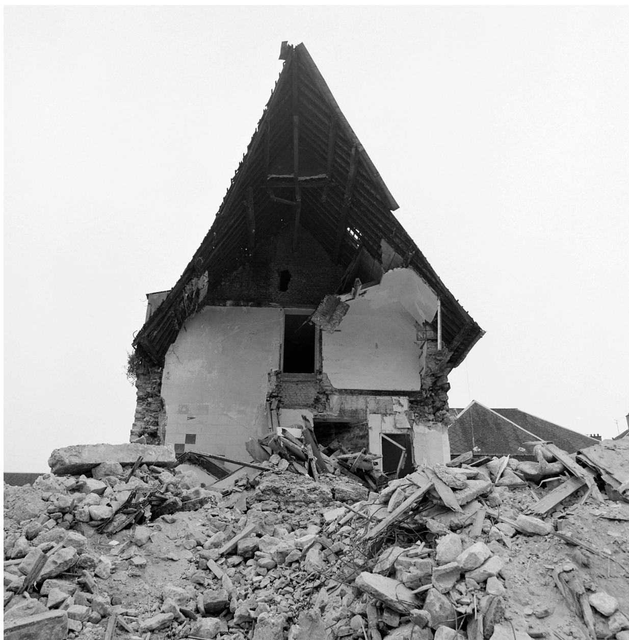
Bâtiment D, charpente.
