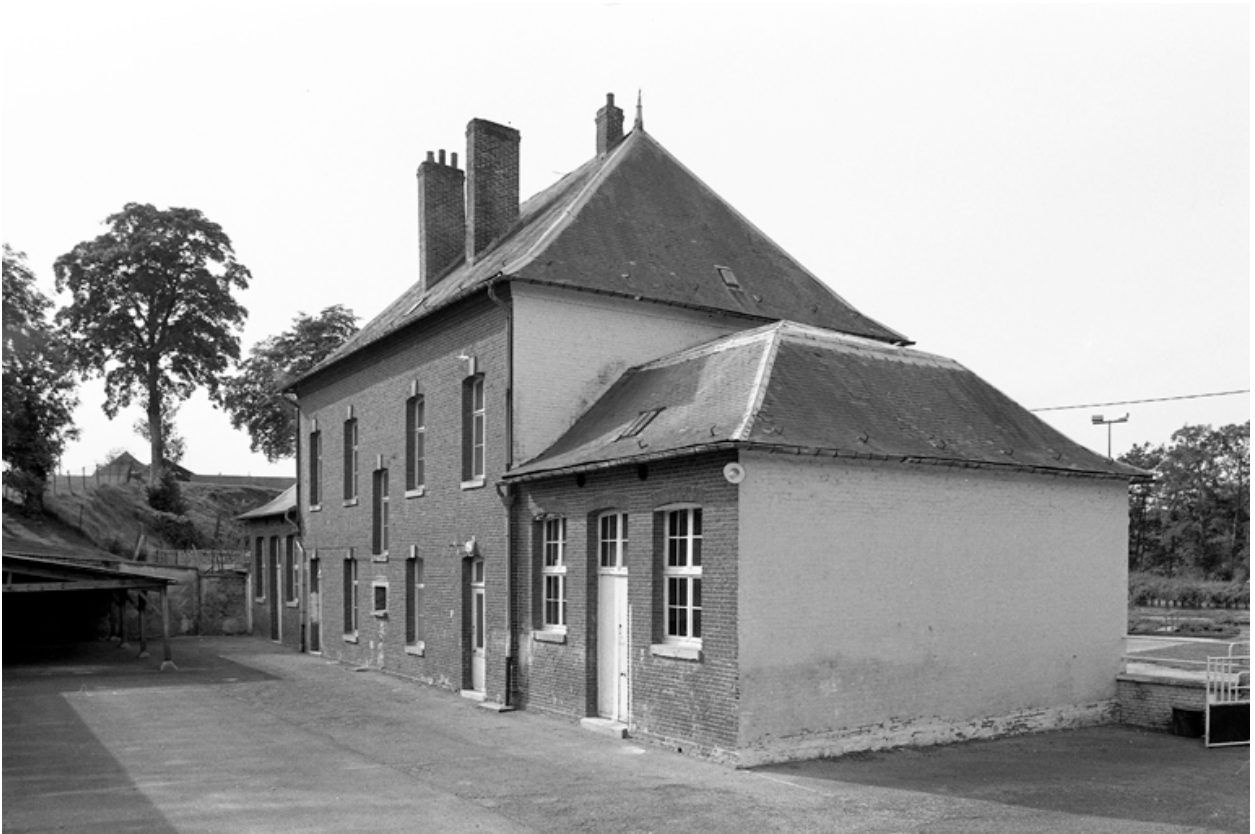
Vue de l'élévation sur cour.
