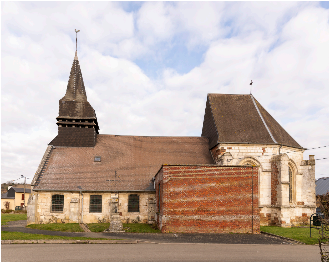
Vue de l'élévation sud.
