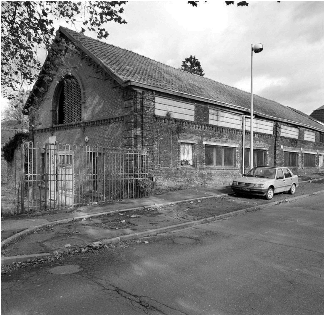
Vue des bâtiments qui abritaient la piscine, les bains publics et le lavoir du Familistère.
