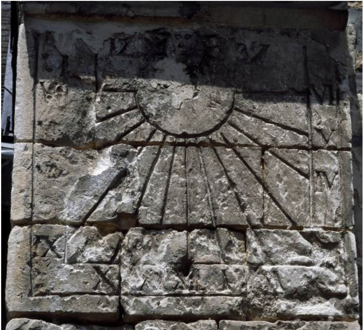
Cadran solaire sculpté sur un des contreforts sud de la nef, portant la date de 1737.
