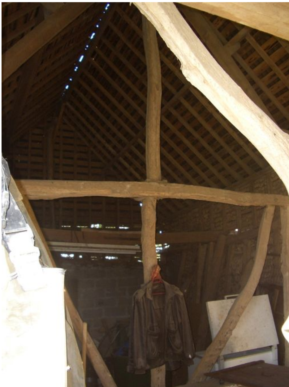
Vue d'une ferme de la charpente de la grange.
