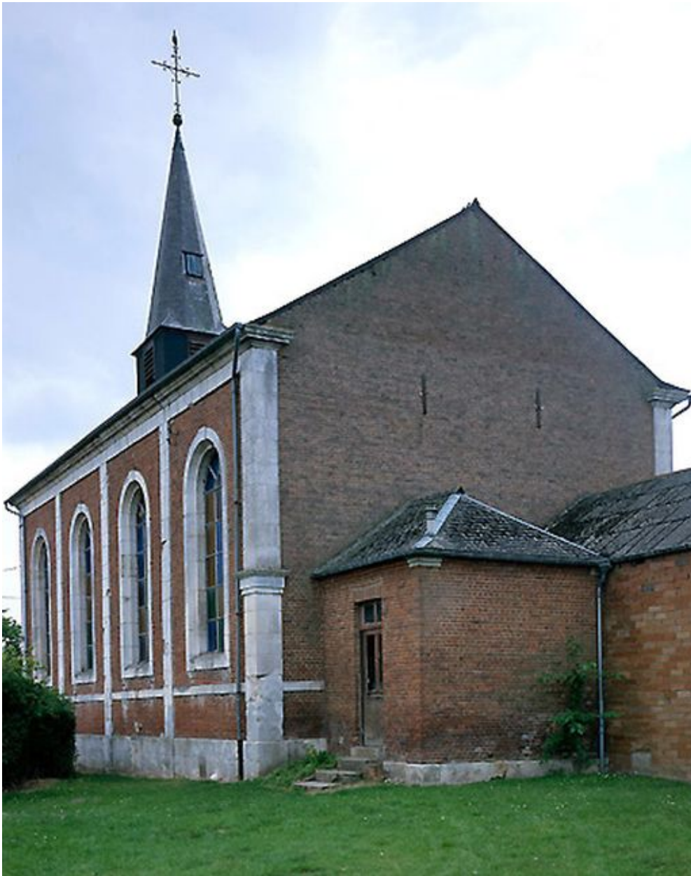
Elévation postérieure du temple et de la sacristie attenante.
