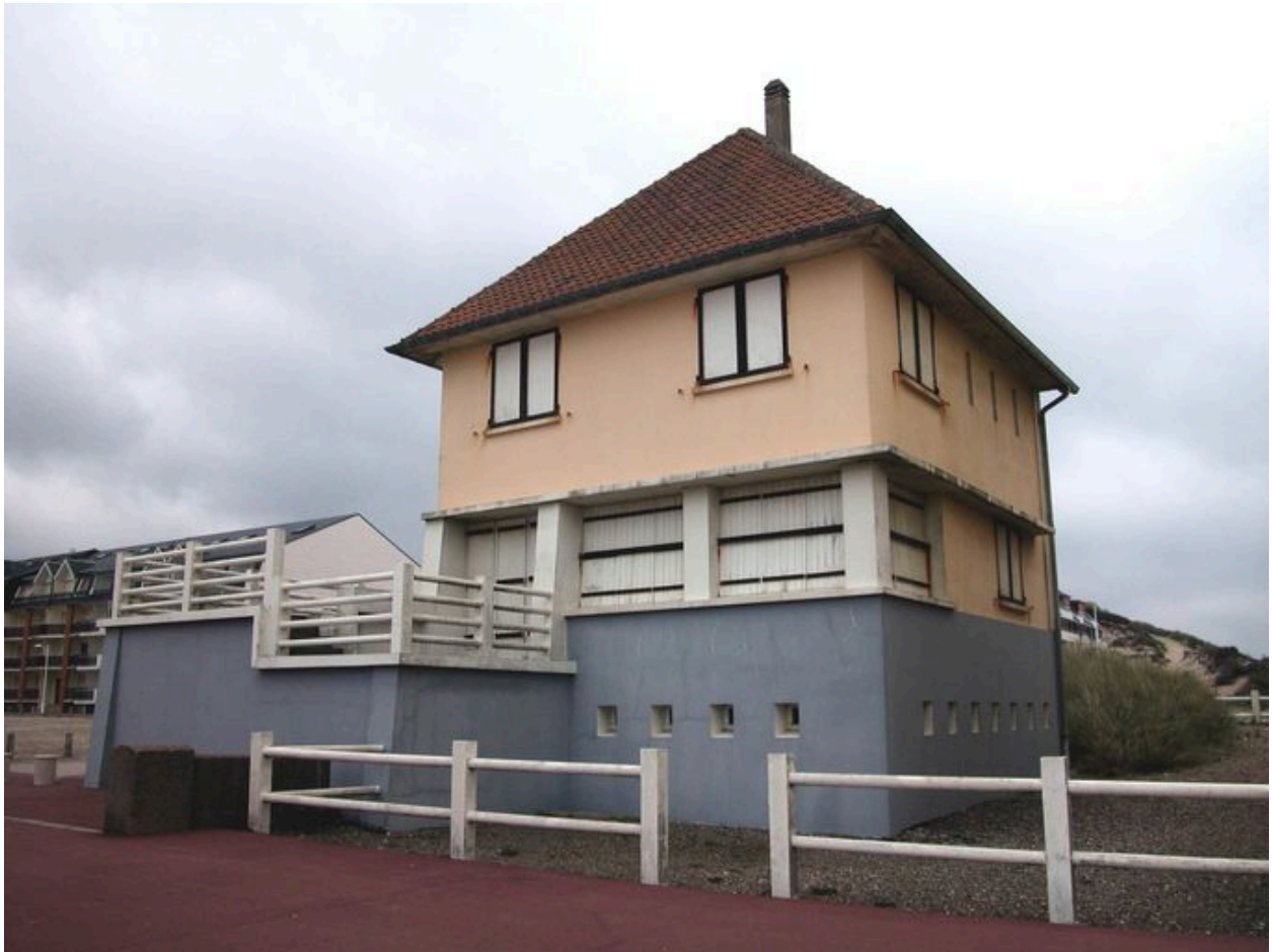
Vue d'ensemble depuis la digue.
