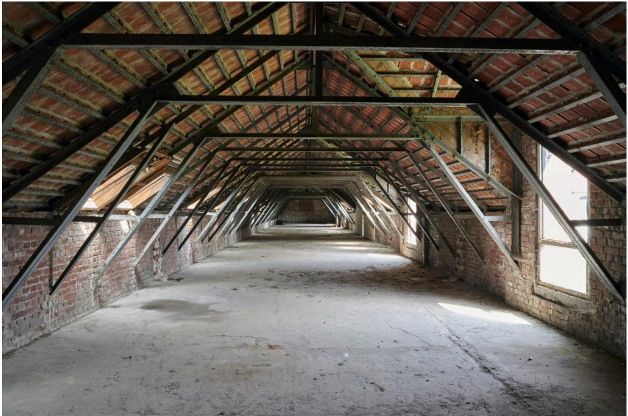
Combles des anciennes grandes étables avec sa charpente métallique apparente.
