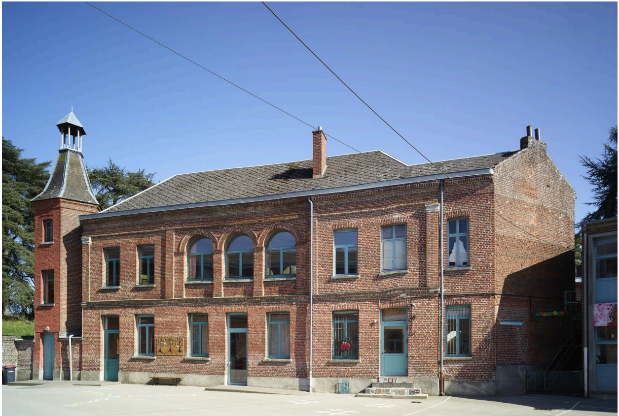
École de garçons : façade sur la cour du bâtiment côté rue Chevray construit en 1879. Vue générale orientée nord-ouest/sud-est.
