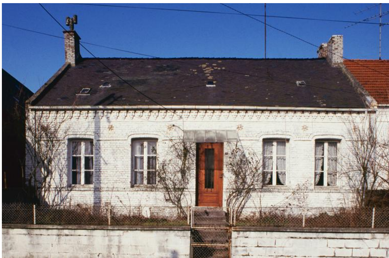
Vue d'ensemble de la façade.
