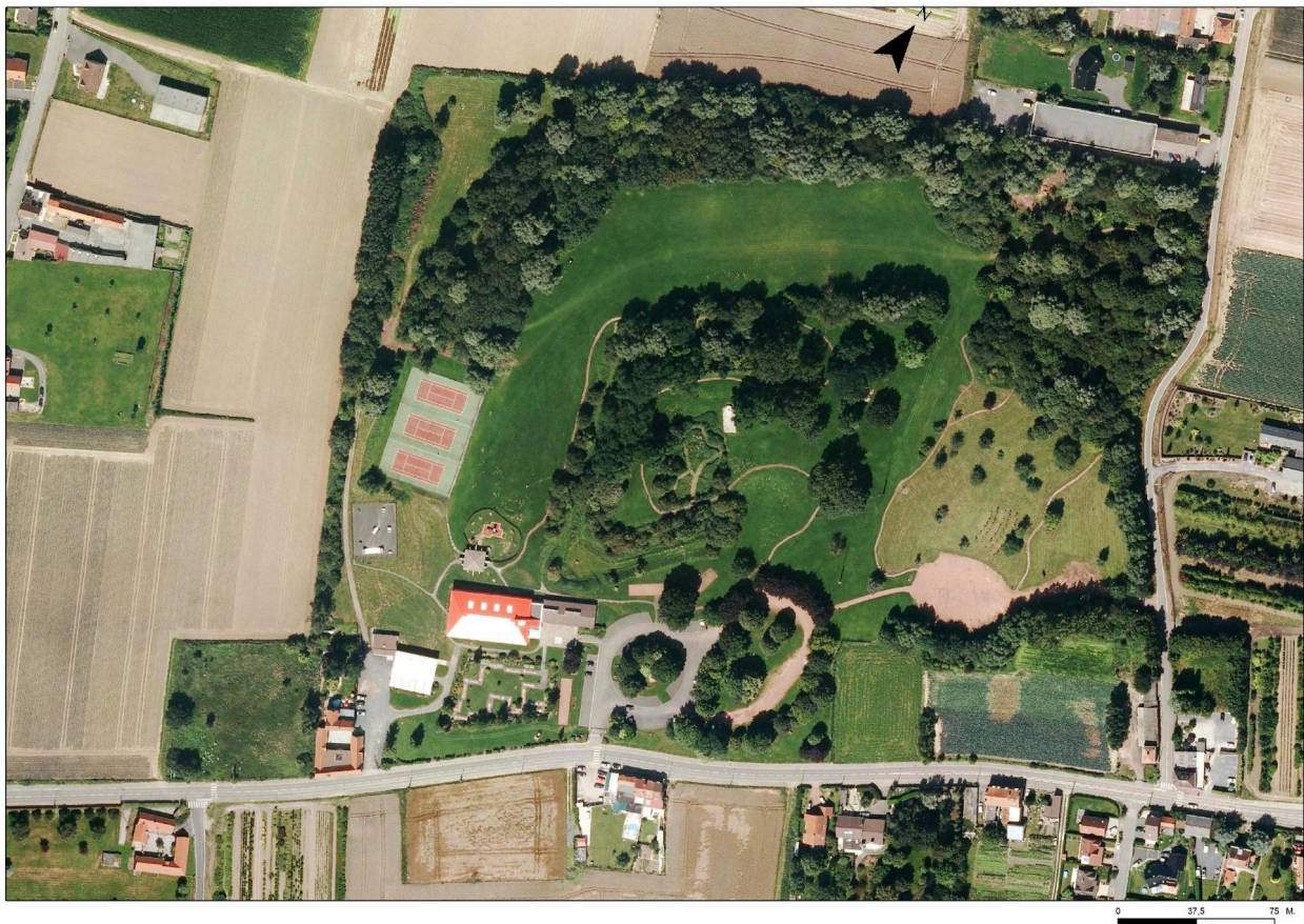
Vue aérienne du fort en partie démantelé en 2015 (Source IGN. Photothèque nationale).
