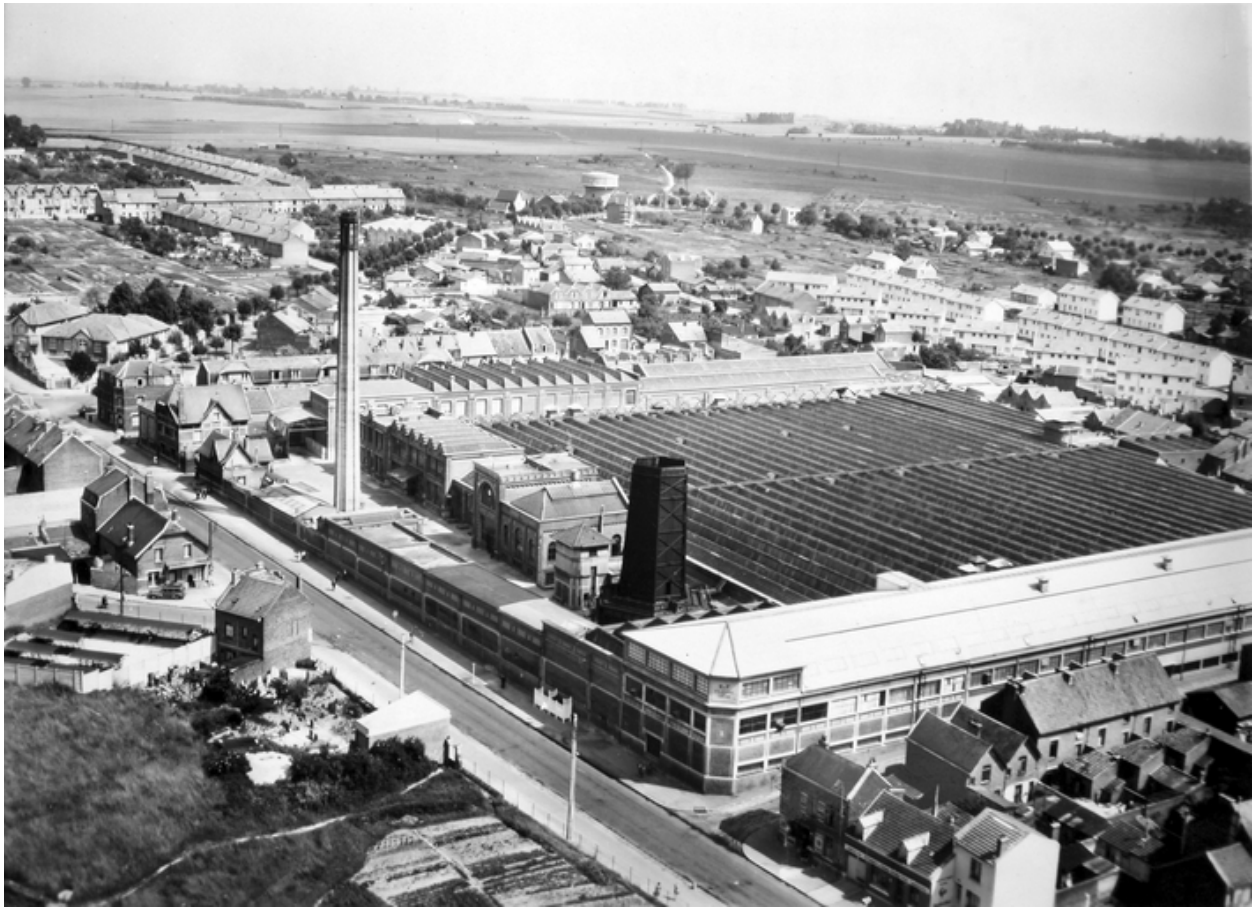
Vue aérienne de l'usine vers 1961-1962 (AD Aisne).
