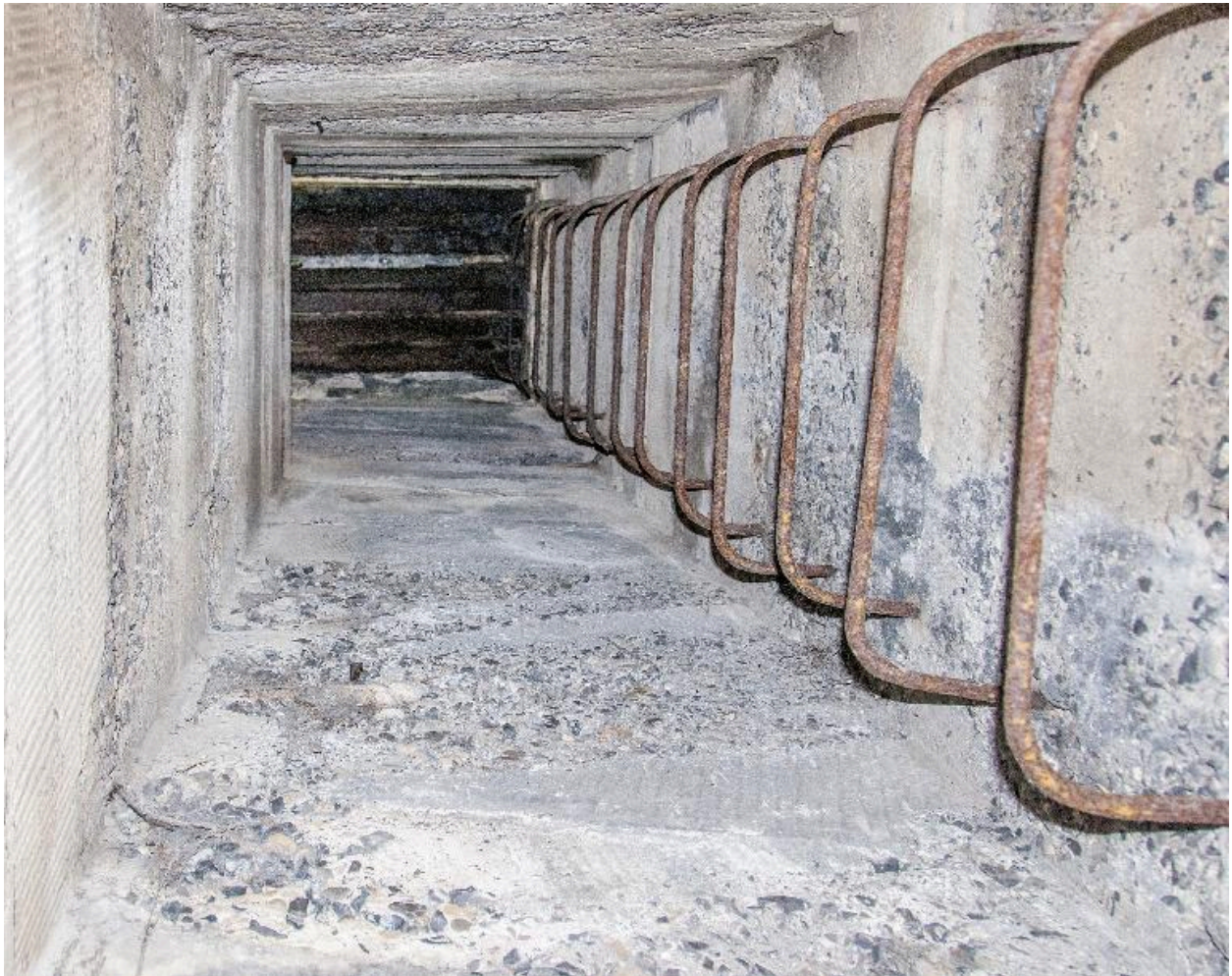
Tour d'observation casematé a. Echelons métalliques menant à la plateforme d'observation
