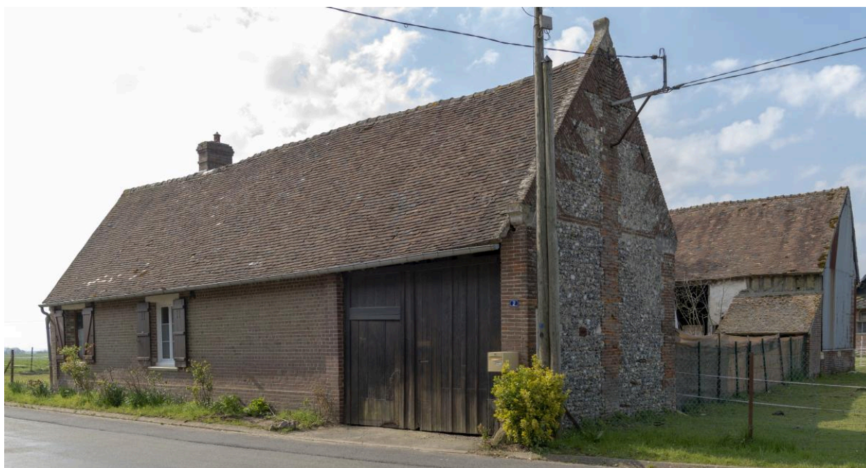
Ancienne ferme, n°2 rue Claude, vue depuis le nord-ouest.
