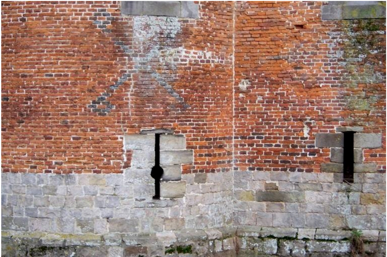
Détail d'un archère et d'une meurtrière.
