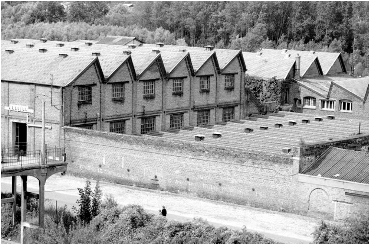
Vue des parties centrales de l'usine
