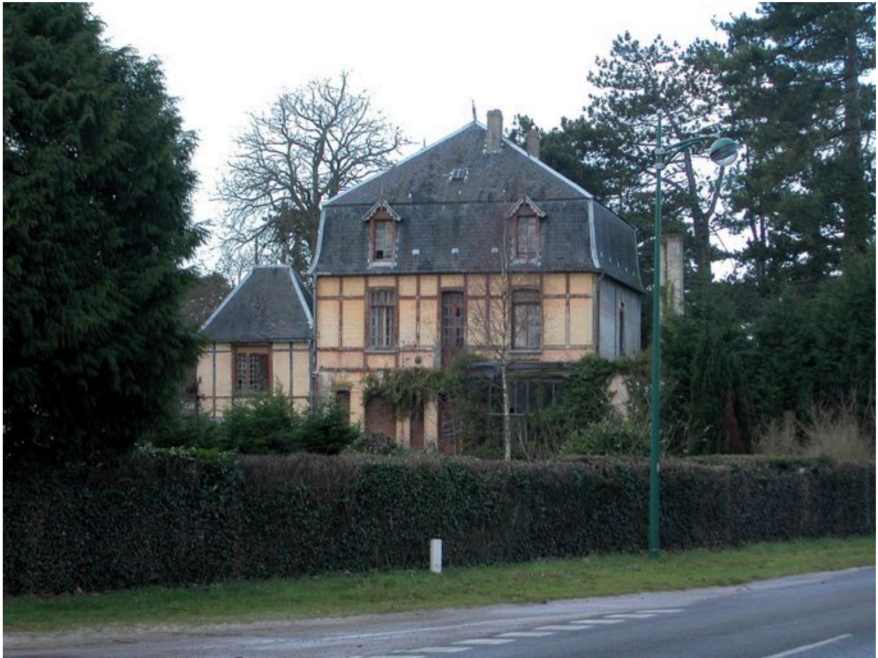
Les Dunettes, villa construite vers 1905 pour Paul Delegrange, à l'origine du lotissement de la Dune.
