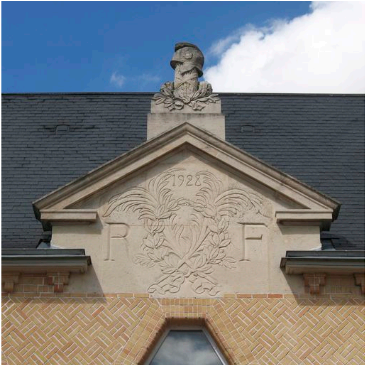
Détail du fronton central portant la date de 1928.
