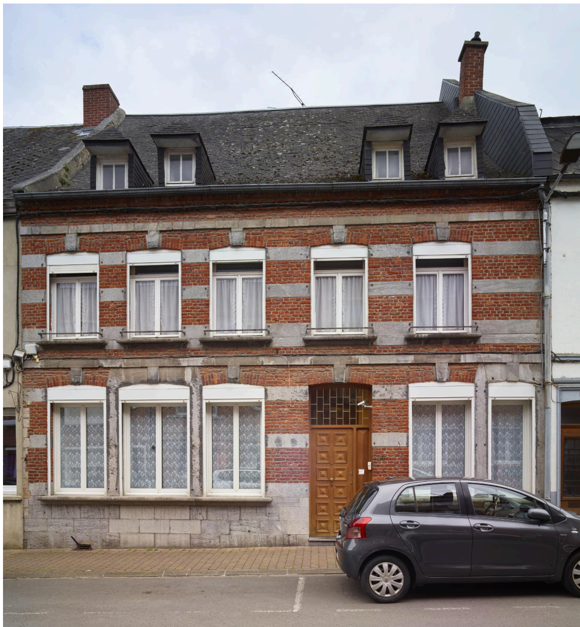
Maison de maître avec date portée (1807) - 14, rue Tanis. Vue de face.
