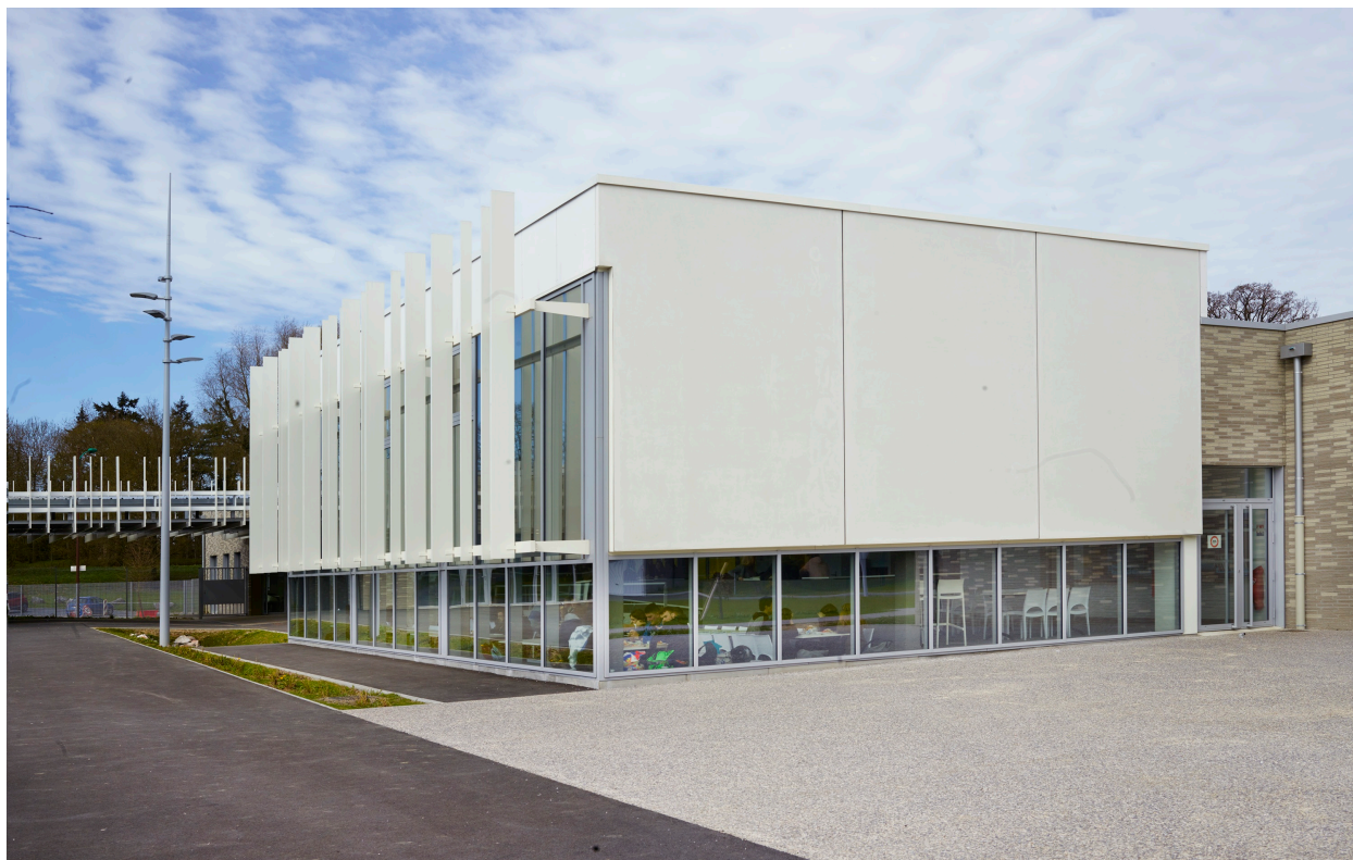
Nouvelle entrée : réfectoire vu depuis la cour
