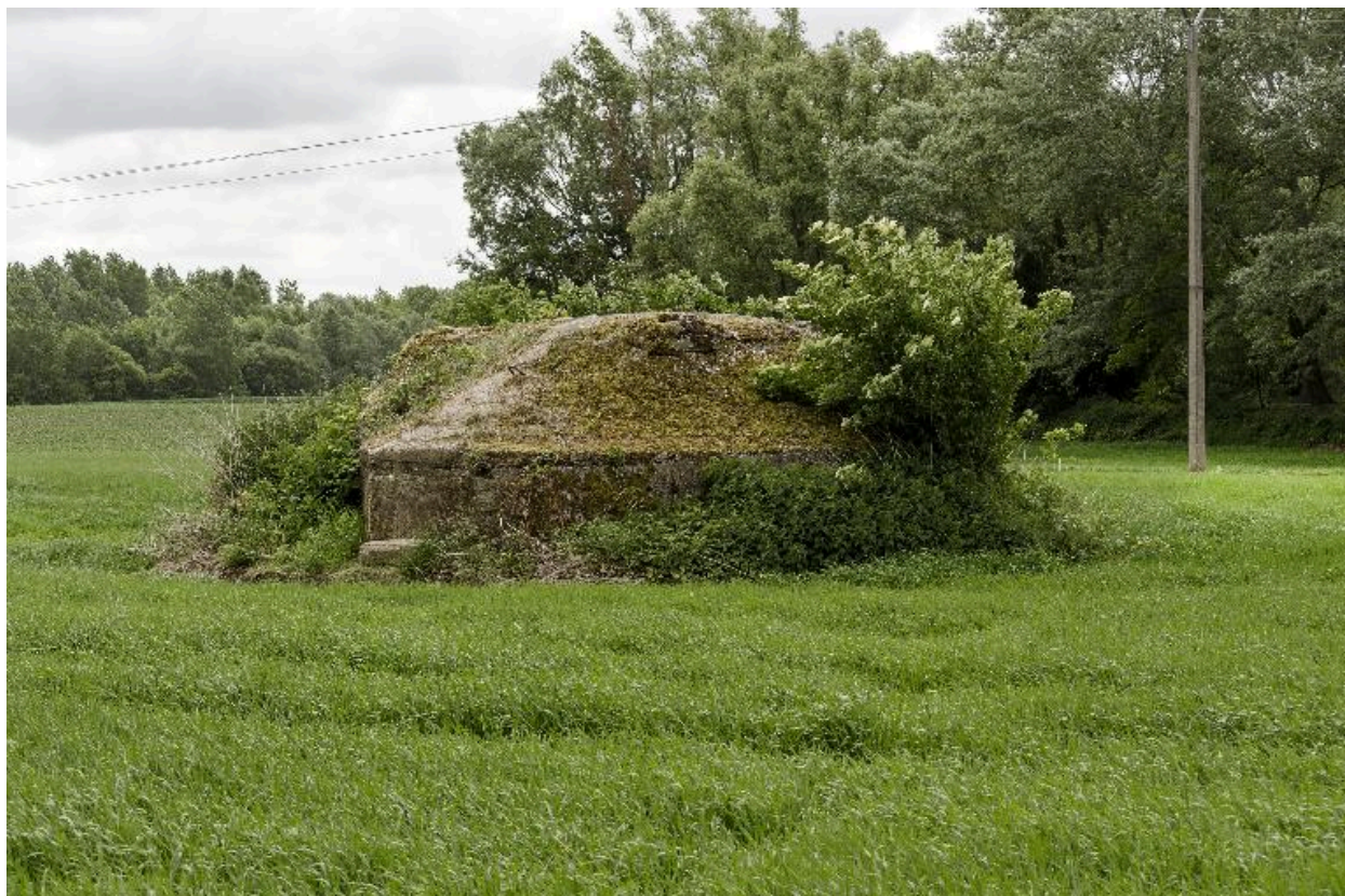
Vue générale vers le sud-est
