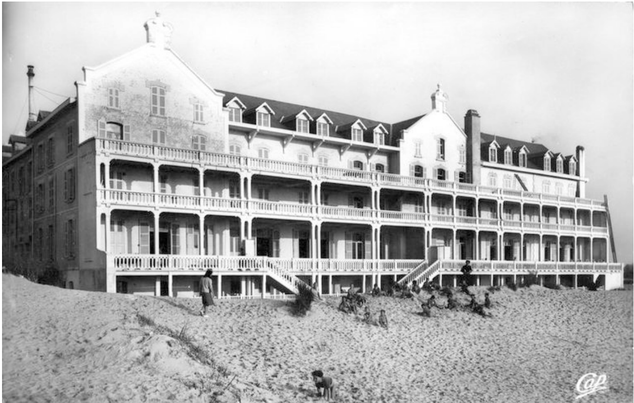
Elévation antérieure après le remplacement des galeries de cure en charpente par des galeries en béton armé, vue générale prise de trois-quarts gauche. Carte postale, vers 1925 (coll. part.).
