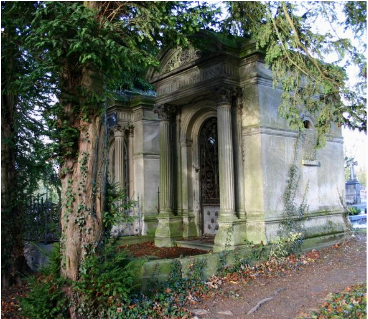
Vue générale, depuis le côté.
