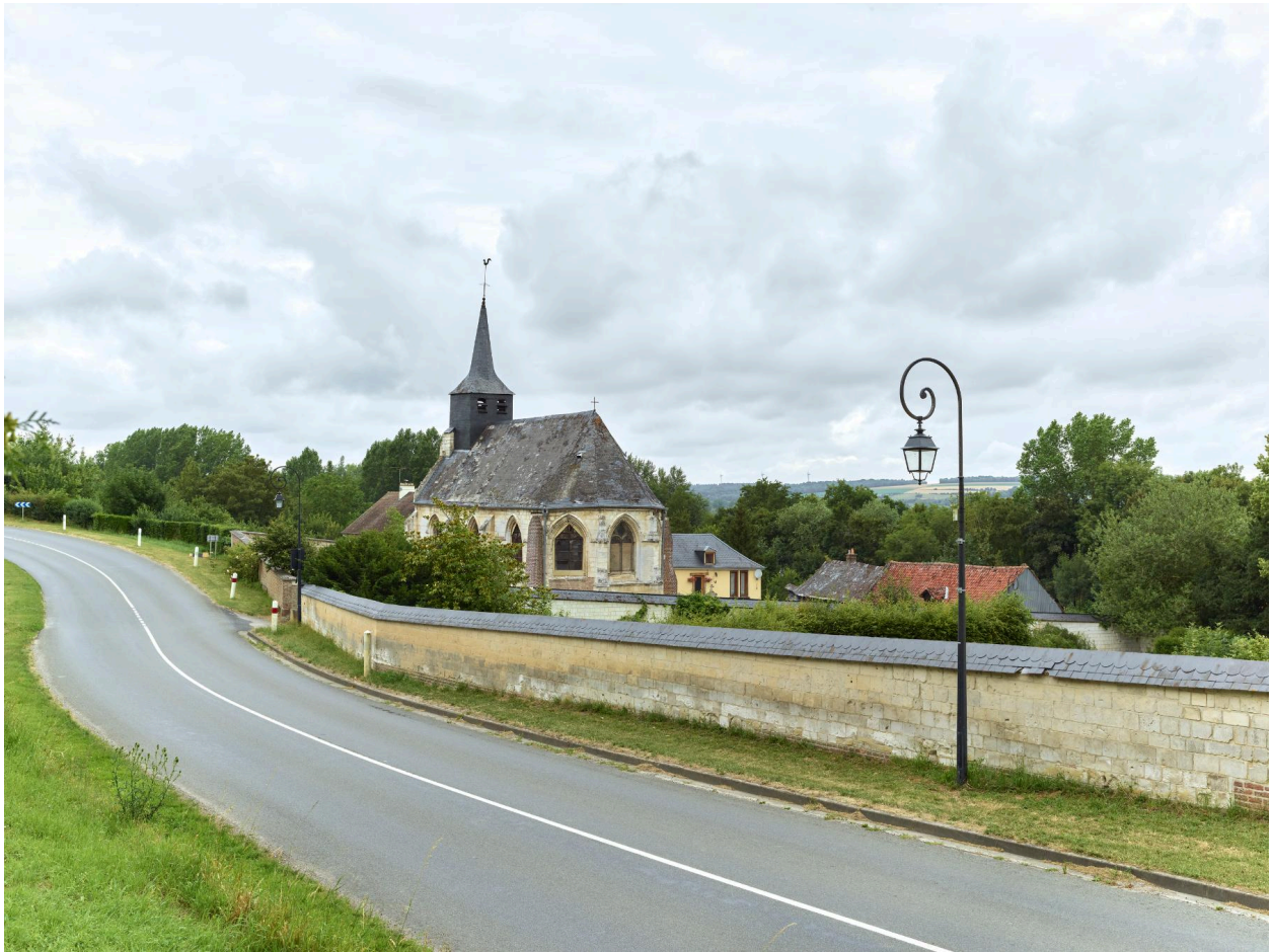
Vue générale de l'église et de son cimetière prise depuis le sud-est.
