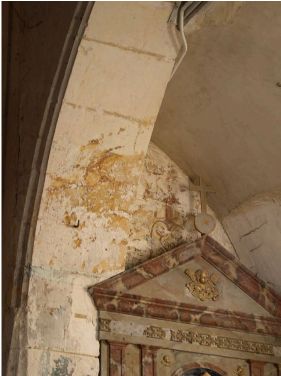
Vestiges de peinture murale, mur est du bas-côté sud.
